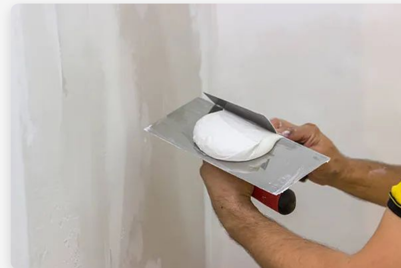
Seina pahteldamine on oluline etapp enne tapeedi paigaldamist
